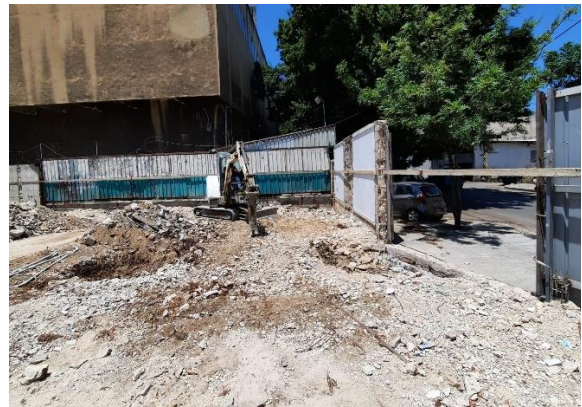
Etat des lieux du chantier. es lieux du chantier. Ouverture du mur sur l'intersection de quartiers communautaires
