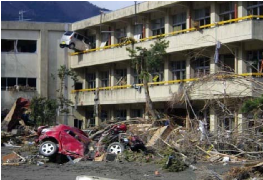
Le bâtiment de l'école primaire de Unosumai
